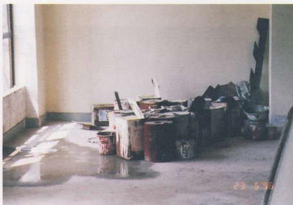
圖28. 具揮發性有機溶劑 - “天拿水”是用來稀釋油漆，具易燃性、能刺激五官及影響中樞神經系統。
