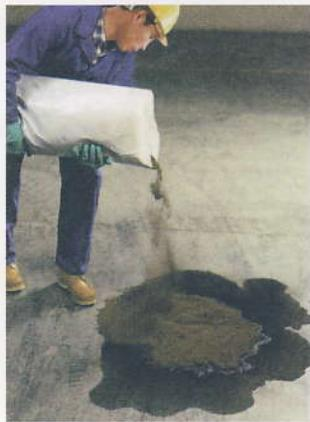
圖 59. 處理少量化學物品溢漏，可使用泥土、沙或吸收劑來覆蓋或圍堵洩漏物。
