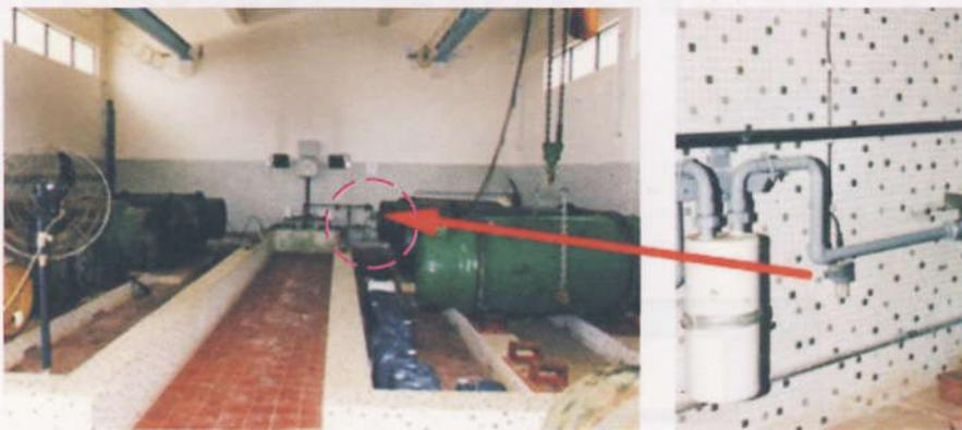
圖40. 安裝在存放氯氣倉的警報系統。
