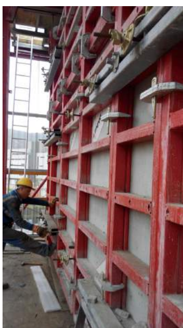
圖3：現場可提供較多位置擺放物料，方便施工
