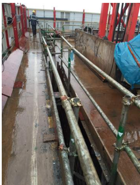
圖2：施工地點能提供安全通道予工人使用
