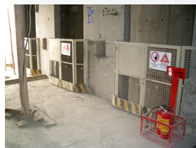
◆ 妥善圍封樓面及平台開口
