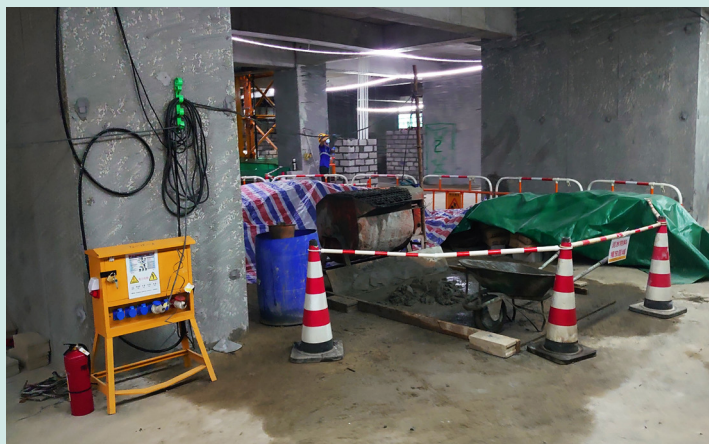
▲ 工地整理措施（物料放置，電線高掛，配備滅火筒）
