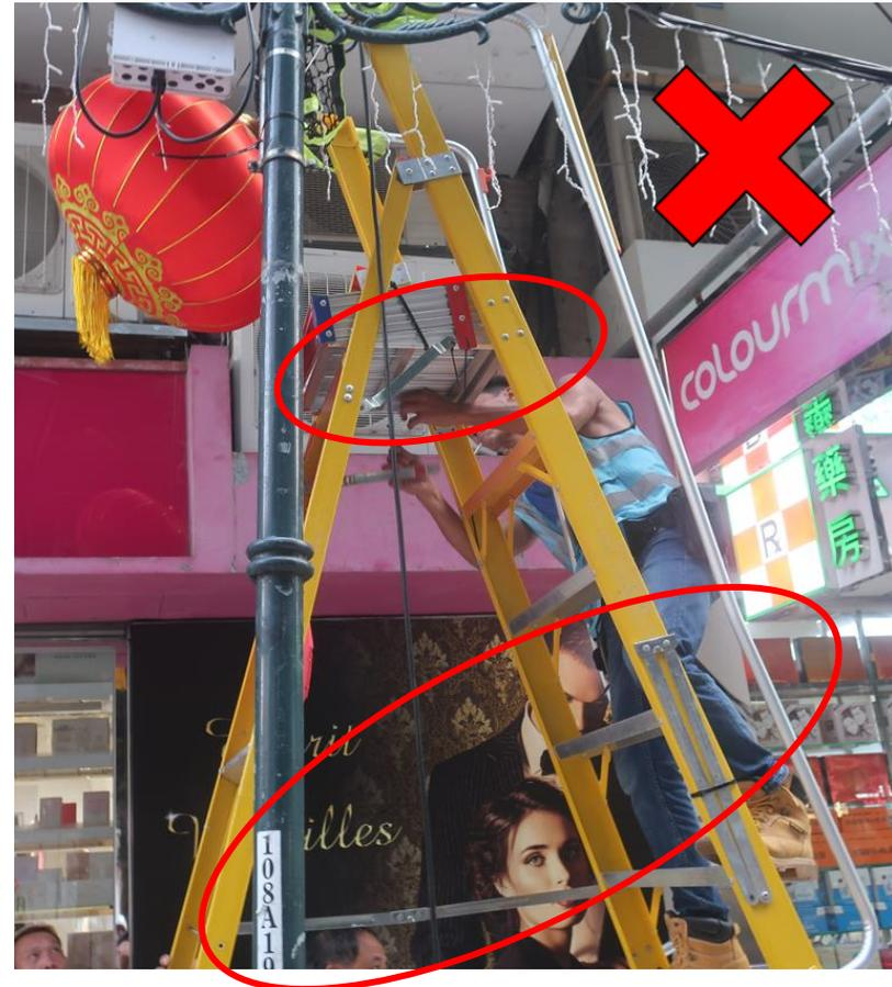
工人所使用輕便工作平台有多個支撐杆已損壞，且用不正確方法修復。
