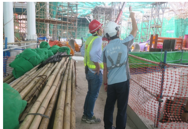
Inspeções minuciosas aos estaleiros de construção civil
