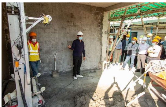
Seminário de demonstração de operações com novo modelo de máquinas automáticas de reboco e de estuque
