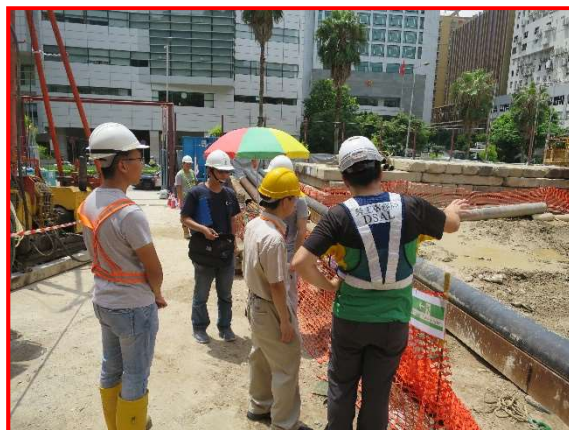
Fiscalização da realização simultânea de diferentes trabalhos nos estaleiros de construção
