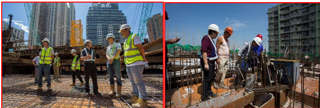
Acções inspectivas a todos os estaleiros de obras de construção
