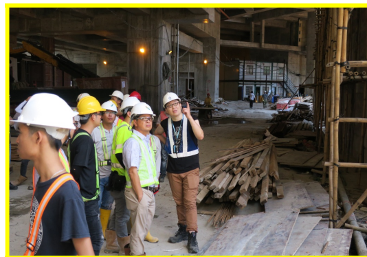
Fiscalização dos trabalhos em altura nos estaleiros de construção
