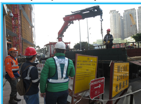
Fiscalização dos trabalhos de elevação e transporte de materiais nos estaleiros de construção
