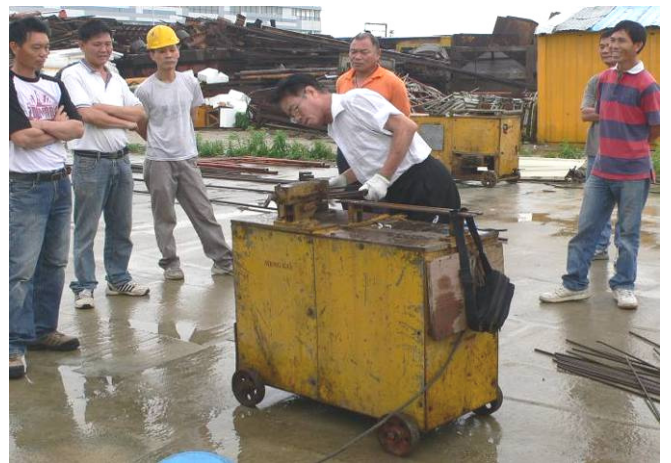
Feira de Emprego para a ampliação das estruturas principais do Novo Terminal Marítimo da Taipa
