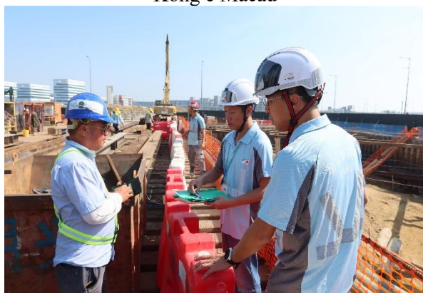
Acções de vistoria nos estaleiros de construção civil
