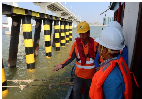
Vistoria dos projectos de obras das pontes
