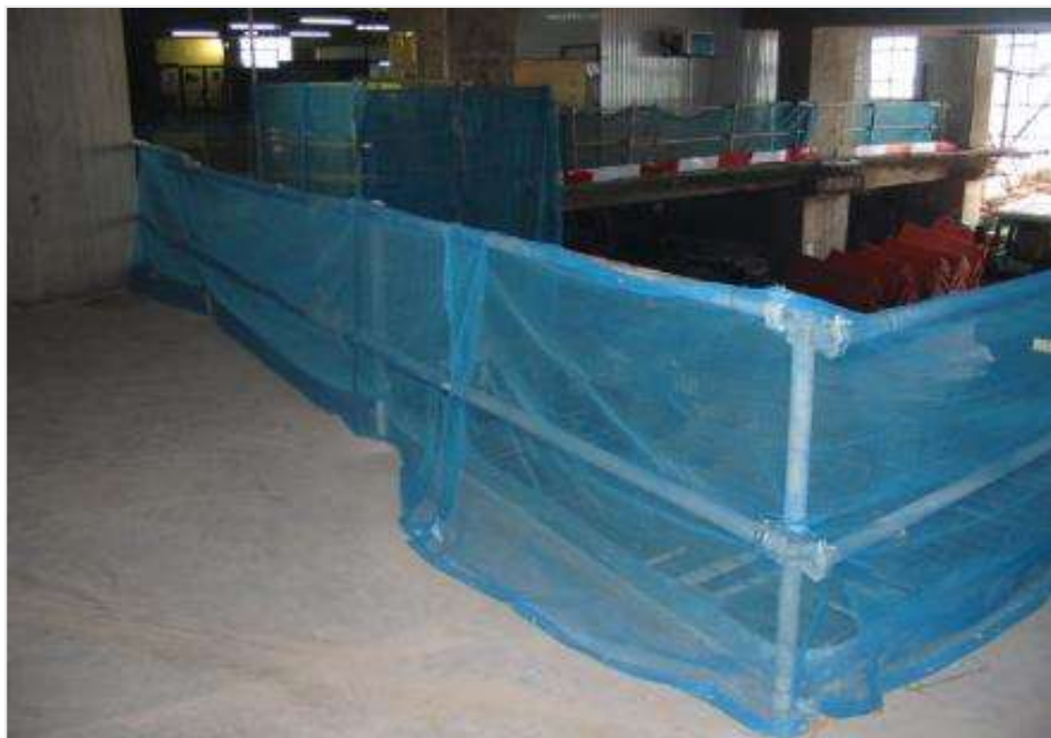
在通道楼边位设置围栏、踢脚板和围网
