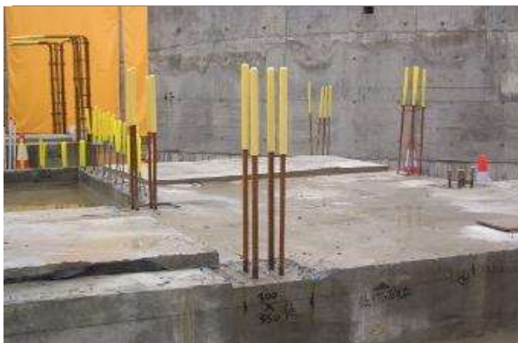
外露钢筋加上护套
