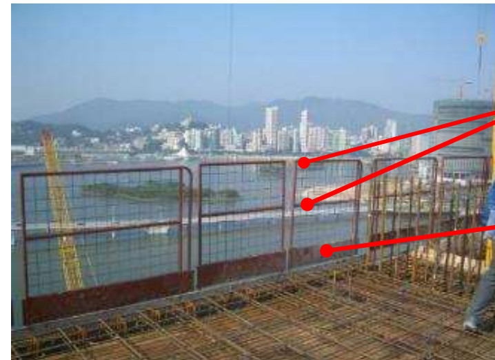
装配式双围栏和踢脚板，稳固可靠，提升施工安全
