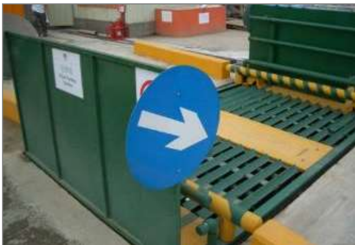
地盘出入口加设洗车池
