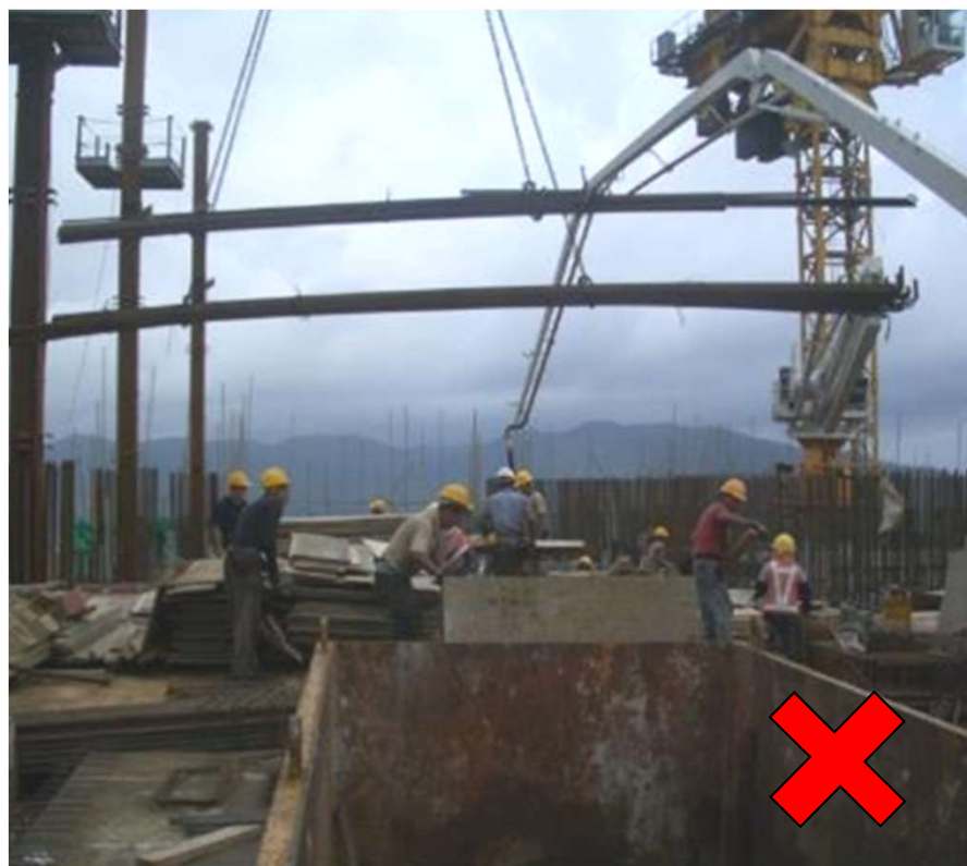
吊运的重物下方有工作人员施工
