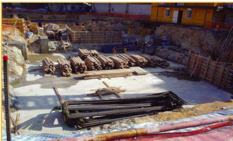
建築材料分類存放並保持通道暢通
