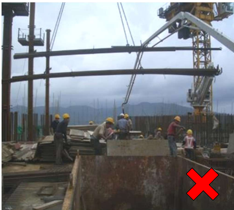
吊運的重物下方有工作人員施工
