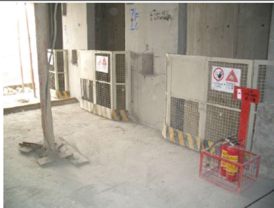
升降機槽口設置圍欄及踢腳板
