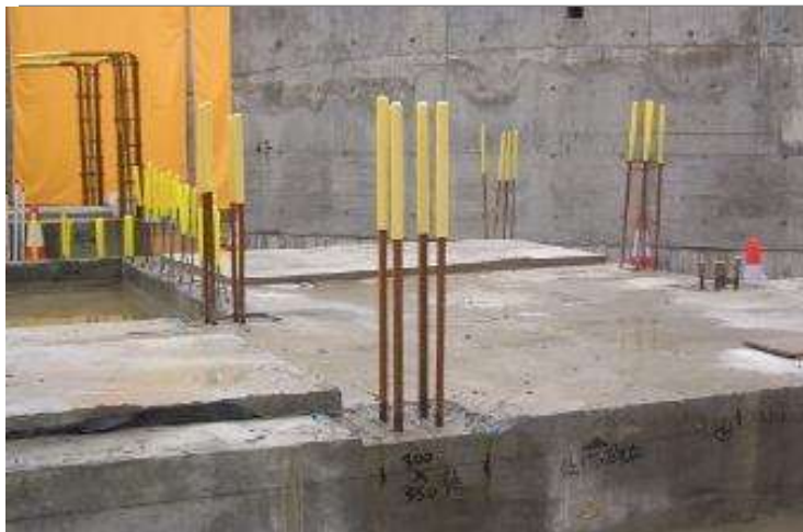
外露鋼筋加上護套
