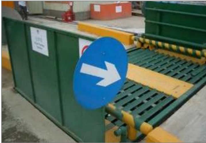
地盤出入口加設洗車池
