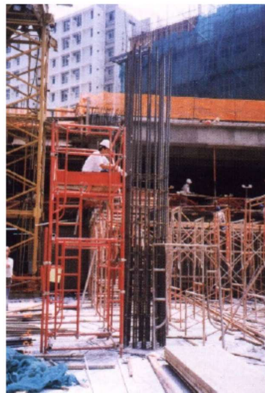
工作平台設有圍欄及踢腳板
